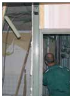
1. den – demontáž původního jádra
