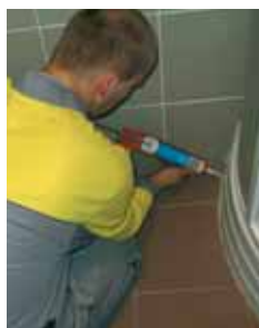
6. den – aplikace silikonové izolace
