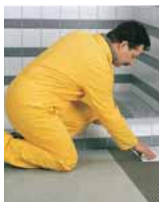
5. den – montáž obkladu a dlažby
