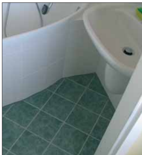
7. den – dokončovací práce
